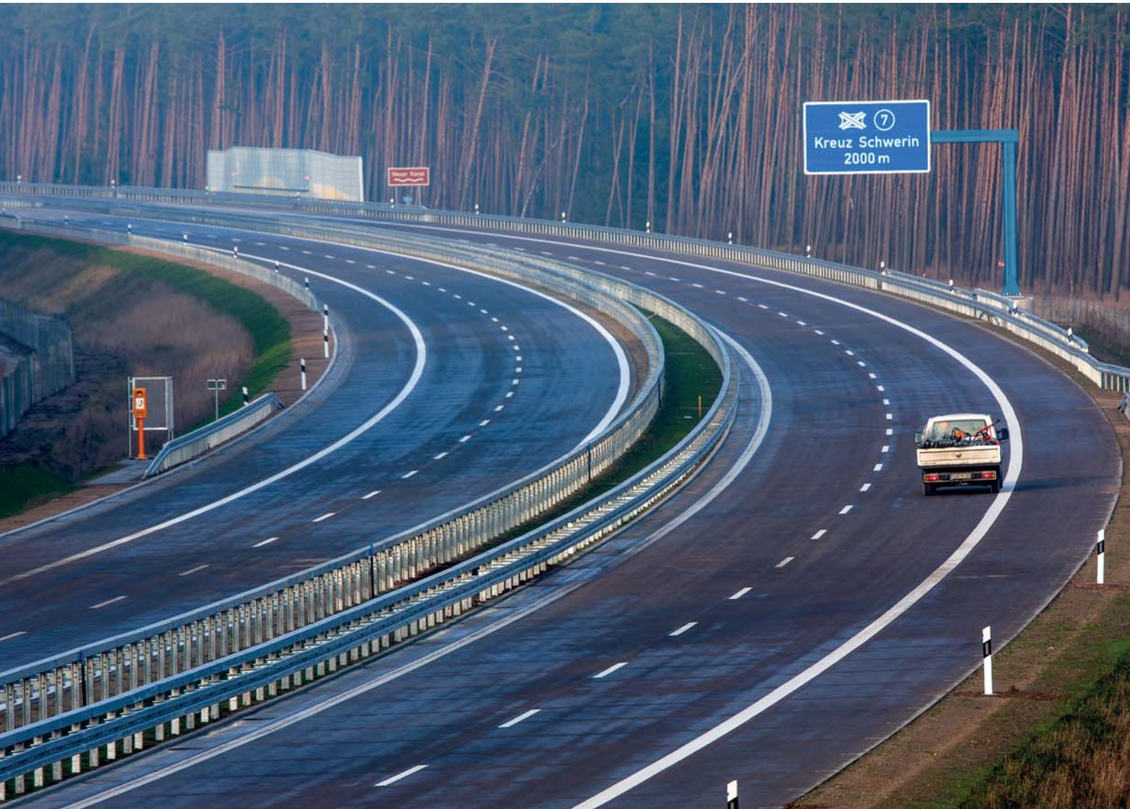
Die A 14 bei Schwerin The A 14 near Schwerin
