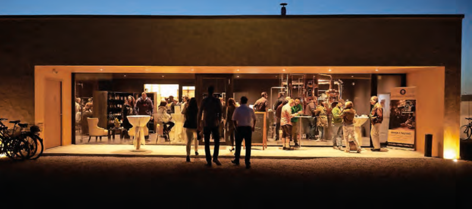
Die Singold Erlebnisdestillerie in Wehringen. Rechts im Bild ist die Brennanlage zu erkennen, daneben befindet sich der Shop. Links liegt der Eingang zum Restaurant, das seit dem Frühjahr 2018 donnerstags, freitags und samstags ab 18 Uhr geöffnet hat.
