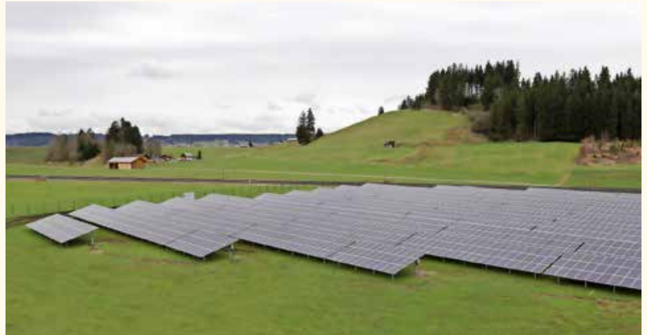
Die Photovoltaik-Freiflächenanlage auf dem Gelände des Umspannwerks in Biessenhofen ist seit Frühjahr dieses Jahres in Betrieb.
