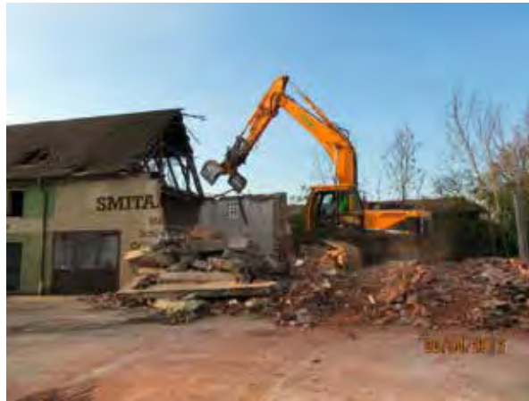
Abbruch- und Baggerarbeiten
