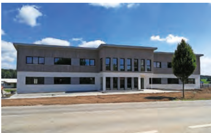
Das neue Verwaltungsgebäude von Thannhauser in Fremdingen.
