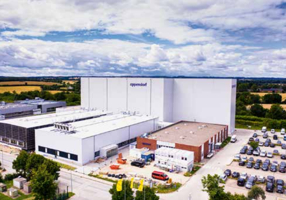
Das Hochregallager (hinten) sowie die beiden neuen Produktionshallen (links und Mitte)
