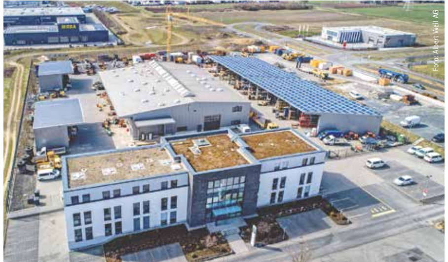
Die Bauunternehmung Albert Weil AG besteht seit 70 Jahren. Das Unternehmen wächst weiter und hat aktuell seinen Bauhof erweitert.
