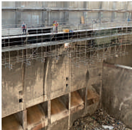
In der Müllverbrennungsanlage Hamm musste Lehde in 25 Metern Höhe neue Stahlbetonbalken anbringen. Foto: Lehde
