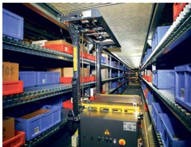
Das vollautomatisierte Shuttle-System mit 133.000 Behälterstellplätzen in Erlensee.
