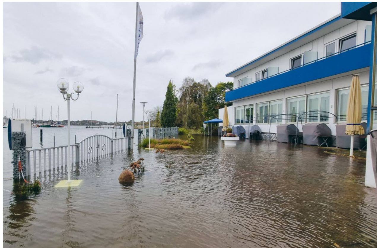
Oben: Das Hotel Strandhalle in Schleswig im Oktober 2023 während der Ostsee-Flut
