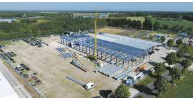
Von der Statik bis zum Fenstereinbau: Stahl 2 bietet seinen Kunden das Gesamtpaket.
