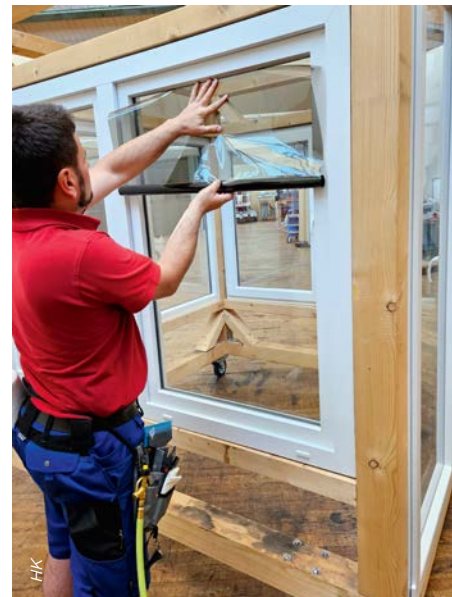
▲ Ein Mitarbeitender von Audax-Keck beim Anbringen einer Fensterfolie in der Lagerhalle in Calw.
