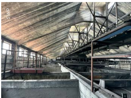
▲ Die Becken der Kläranlage in Eutingen. Aus dem temperierten Abwasser wird Restwärme gewonnen, die zur Beheizung des Nahwärmenetzes dient.
