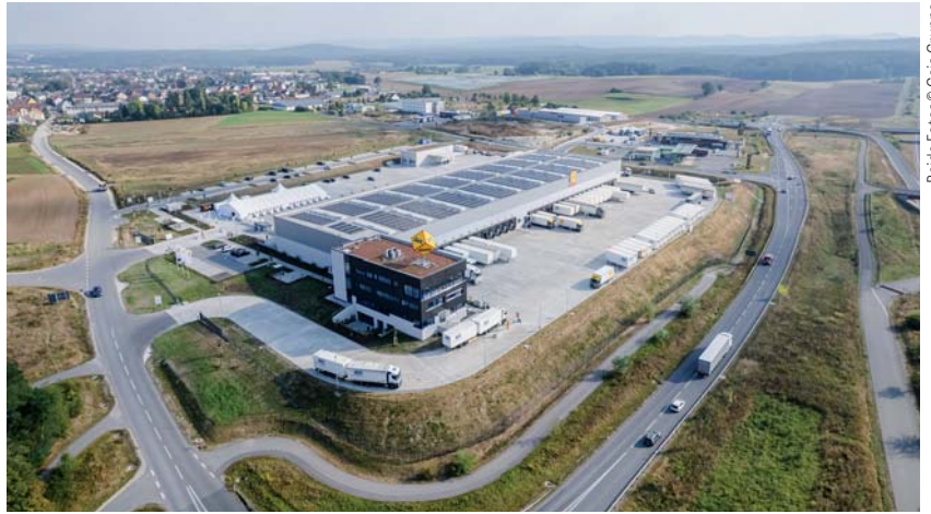
Das neue Speditionsterminal der Geis Gruppe in Ebersdorf ist mit Photovoltaikanlage, Dachbegrünung und Holz-Hybrid-Bauweise der Prototyp einer nachhaltigen Gebäudegeneration.
