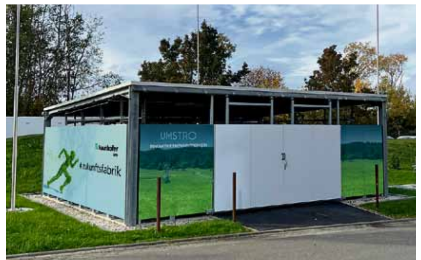
H 2 -Kraftwerk des Fraunhofer IWU in Chemnitz. Foto: Fraunhofer IWU
