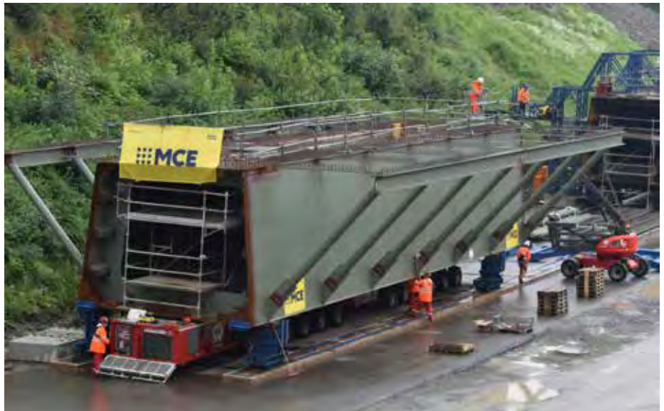
Die ersten Stahlteile für den Ersatzneubau sind angeliefert und werden nun im Taktkeller für den Bau der Rahmedetalbrücke vorbereitet, bevor sie „hinausgeschoben“ werden.
