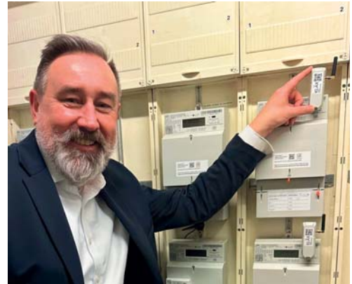
Autor Michael Schulz mit einem sogenannten LoRaWAN-Zähler. Drahtlose Netzwerktechnik ermöglicht das Monitoring von Zählerständen in Echtzeit.
