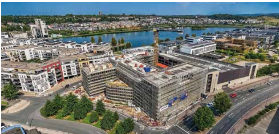
Die Luftaufnahme zeigt den Stand des neuen Baus am Phoenix-See, der in puncto Nachhaltigkeit beispielhaft ist. Fotos: BIG direkt gesund/Stephan Schütze
