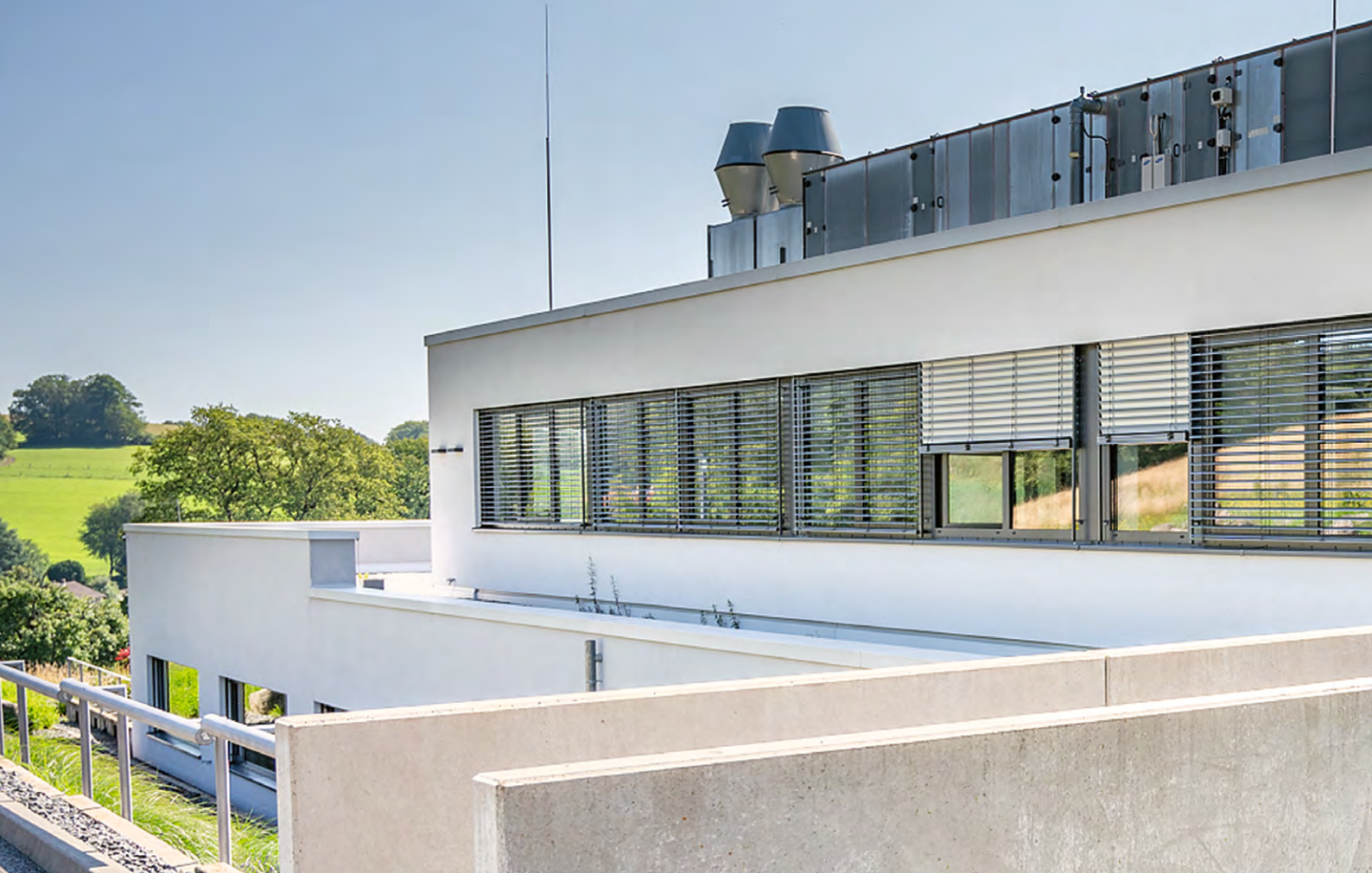
Der Neubau von Kopp Schleiftechnik verfügt über ein System der Wärmerückgewinnung, das beträchtliche Energiemengen einspart. Foto: Thomas Neu
