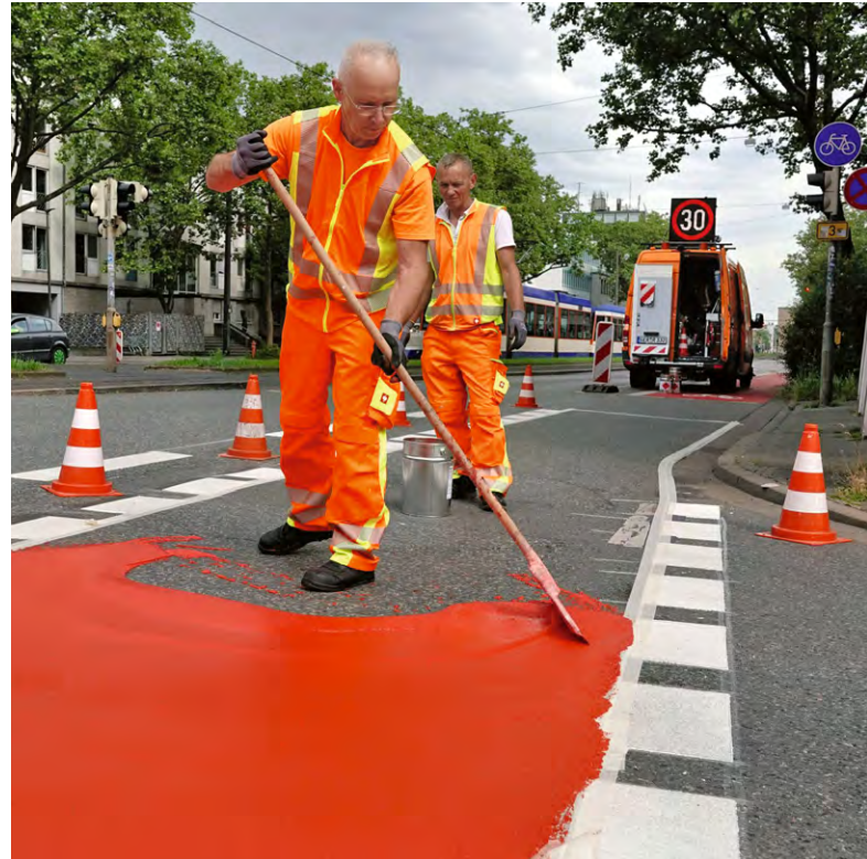
Das nachhaltige Bindemittel von Röhm kommt in Darmstadt bei der Markierung eines Radwegs zum Einsatz. Foto: SWARCO RMS
