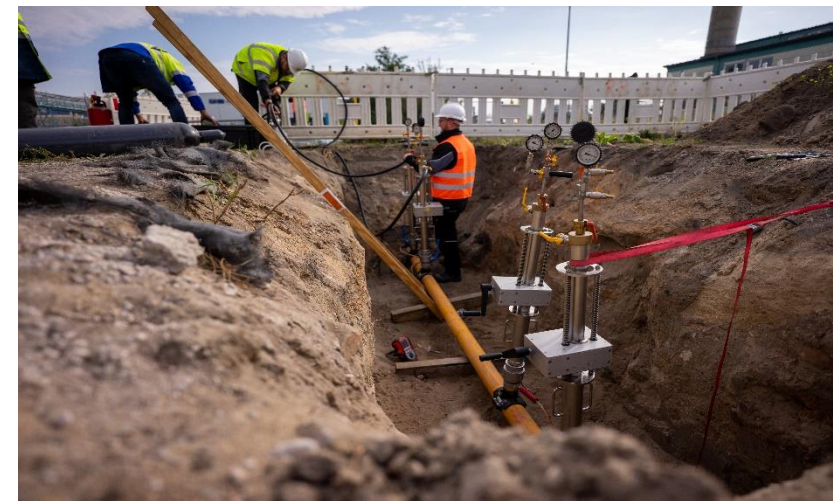
Leitungsarbeiten: Schleichgasmengen-Messung (Blasensetzen)
