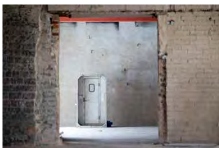
Die Arbeiten im IHKLW-Gebäude werden mit dem Denkmalschutz abgestimmt.
