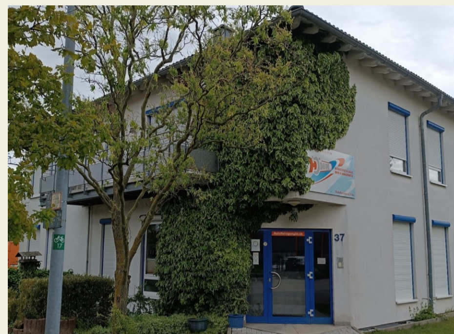
Enni-Verwaltungsgebäude in Moers Kombinations-Fassade in Vorhangbauweise (ca. 600 m 2 begrünte Gebäudewandfläche)
