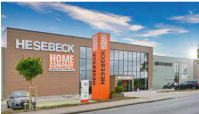
Vorderansicht des Neubaus
