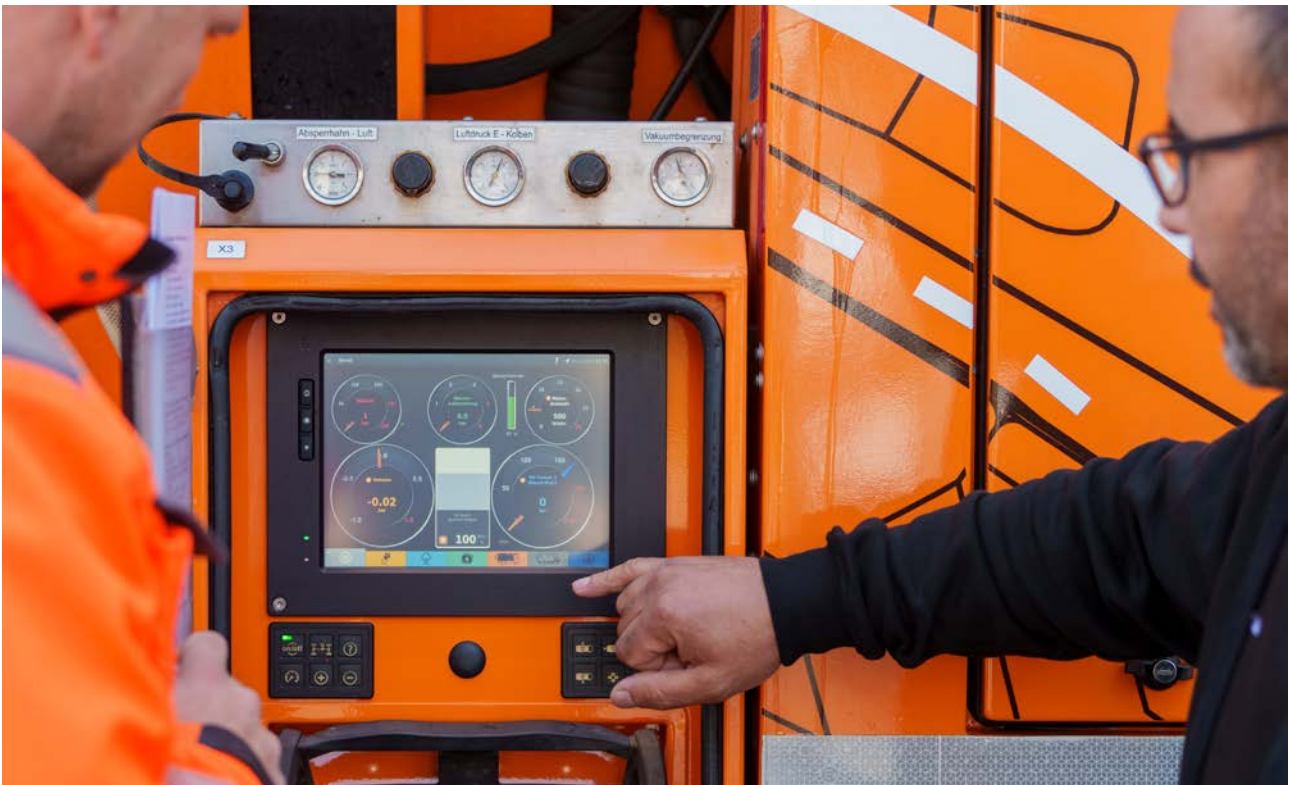
Abbildung 12: Prüfen von Parametern nach Herstellervorgabe (Quelle: VDRK)
