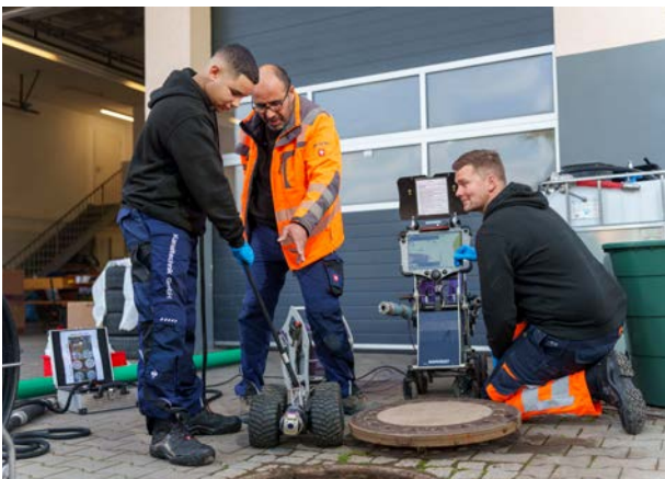
Abbildung 8: Schachtinspektion mit Inspektionskamera (Quelle: VDRK)
