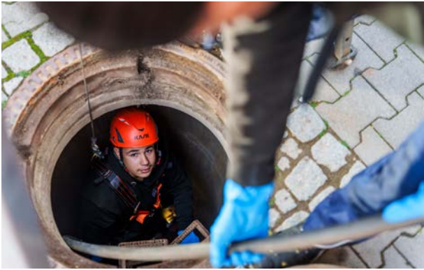
Abbildung 4: Tragen der Persönlichen Schutzausrüstung (Quelle: VDRK)
