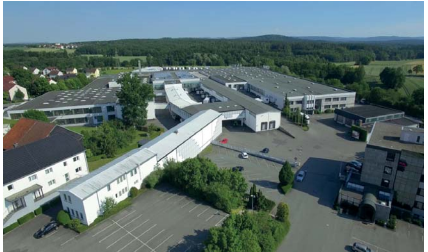
Werksgelände der W. Schillig Polstermöbelwerke in Ebersdorf-Frohnlach
