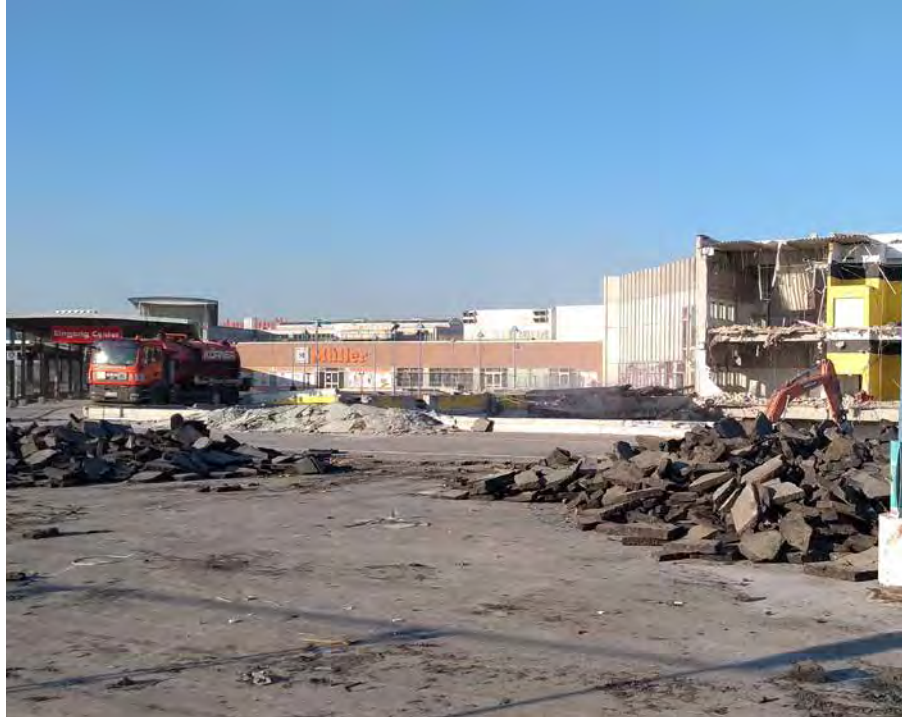
Die Bauarbeiten am Einkaufszentrum sind in vollem Gange.
