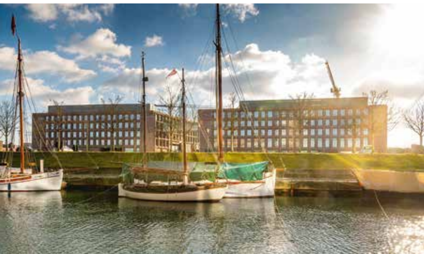
Der Neubau der IB.SH in Kiel
