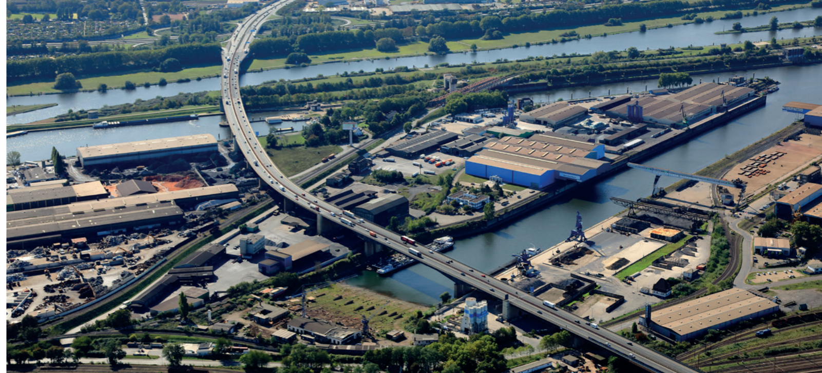
Die Berliner Brücke auf der A59 in Duisburg.
