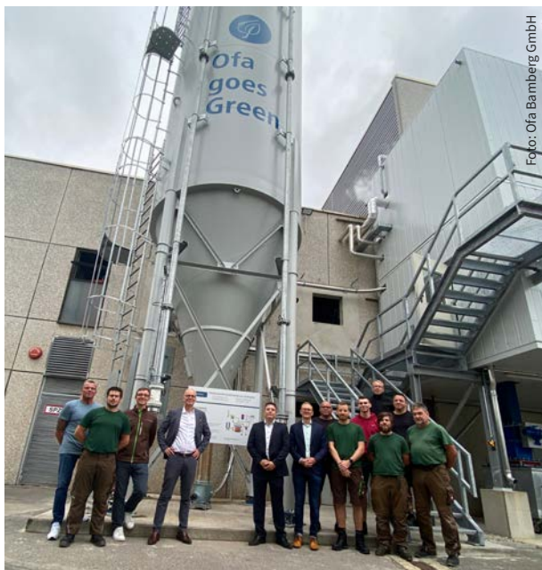
Die Teams von Ofa Bamberg und Schmidmeier NaturEnergie vor der neu errichteten Biomasseanlage.
