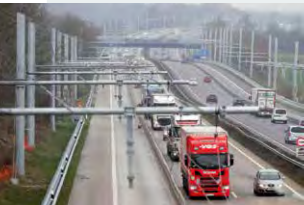
Oberleitungsteststrecke auf der A 1
