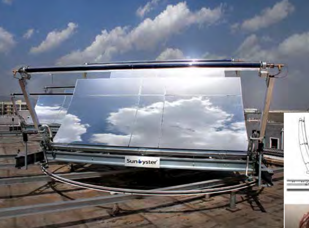
Von der Natur inspiriert: Eine Auster schließt sich bei Gefahr – die SunOyster tut dies ebenso automa- tisch, etwa bei Sturm oder Hagel; Bild links: SunOyster in Shuozhou, China
