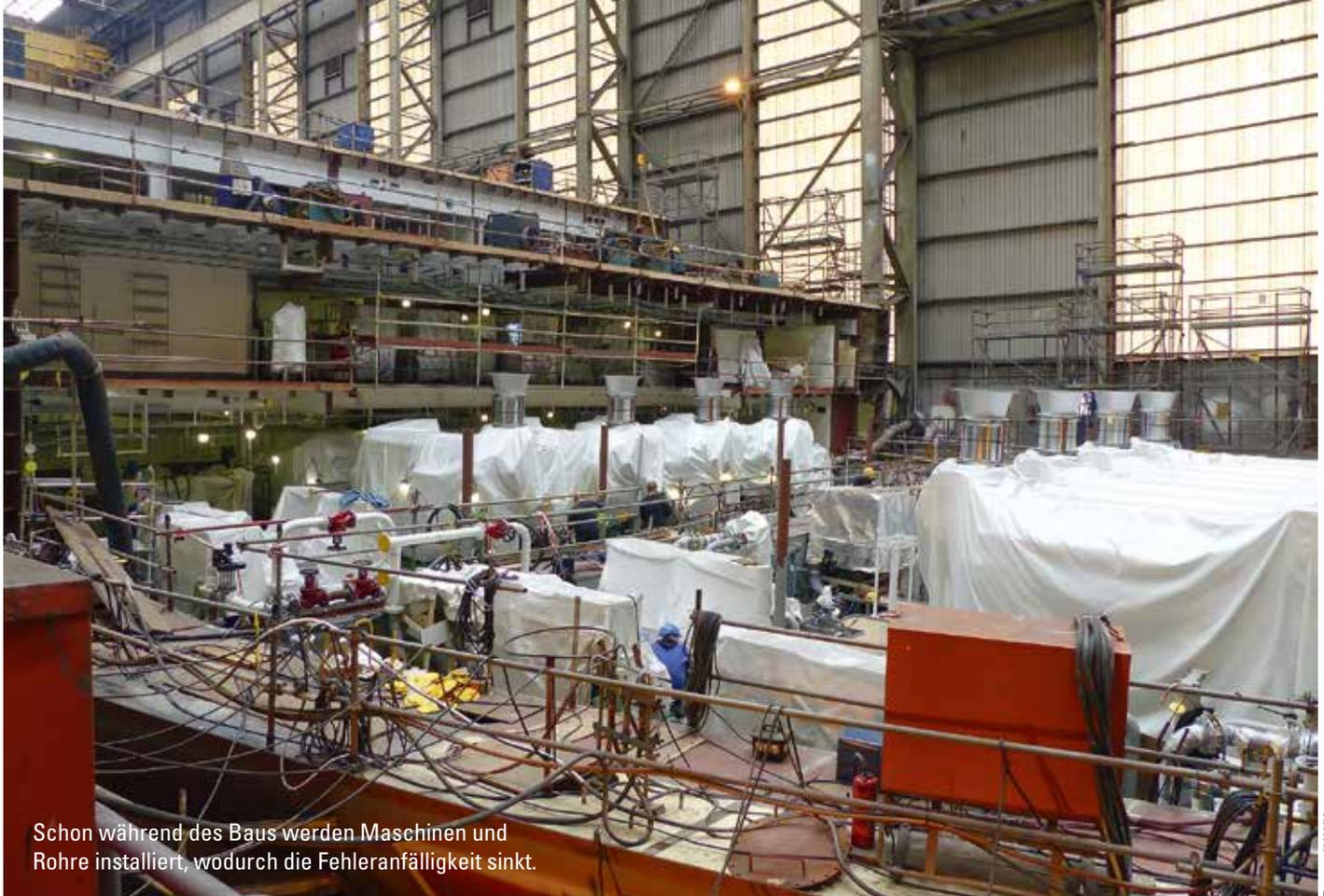
Schon während des Baus werden Maschinen und Rohre installiert, wodurch die Fehleranfälligkeit sinkt.
