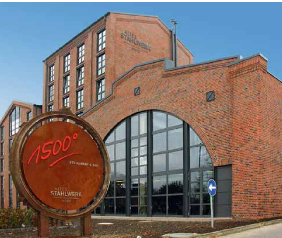
Foto: Stahlwerk NMS
