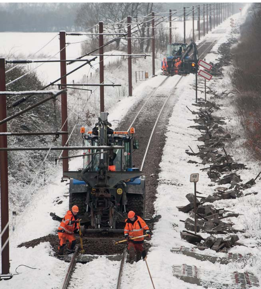
Reparatur in Rekordzeit: Schwellenaustausch nördlich von Sommersted
