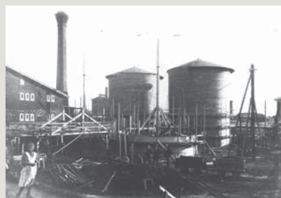
Alsen: Handwerker beim Bau einer Siloanlage um 1890.
