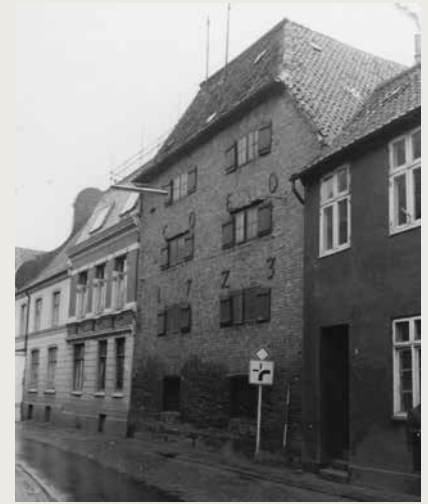
Ehem. Otte-Speicher in der Langebrückenstraße von 1723.
