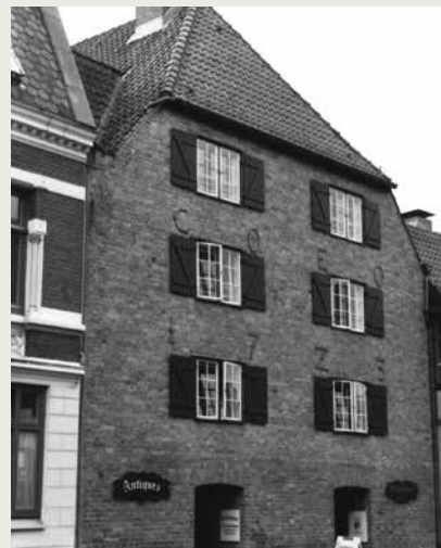
Ehem. Otte-Speicher in der Langebrückenstraße von 1723, von Sieck erworben zusammen mit dem zugehörigen Kontorhaus.
