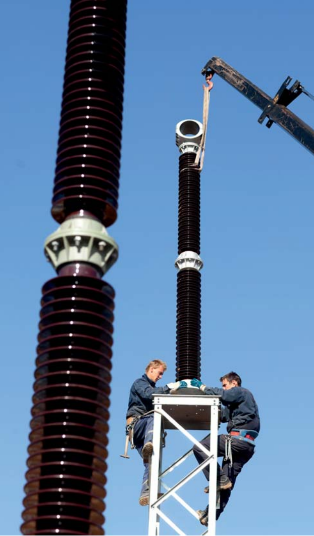
Montage einer Spule an einer Umspannstation
