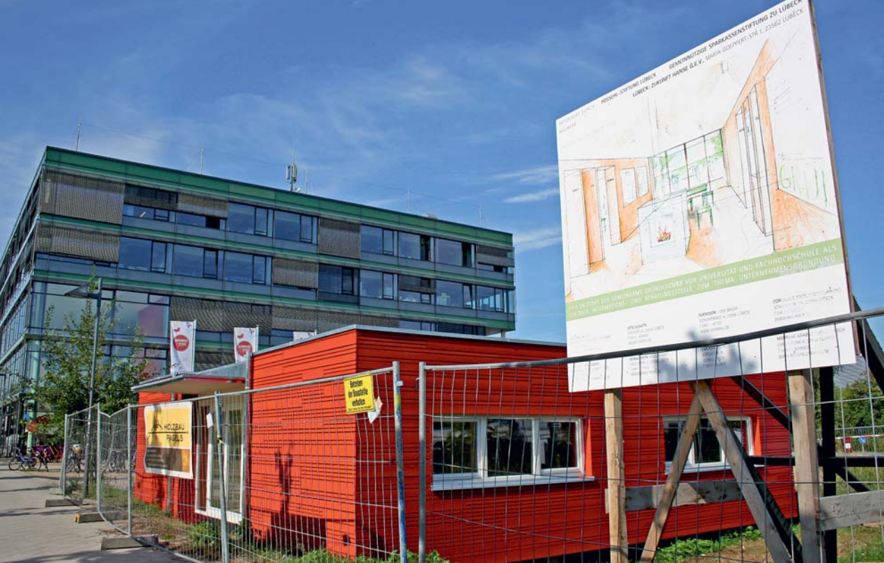
Der „Gründer-Cube“ auf dem Lübecker Campus kurz vor der Fertigstellung
