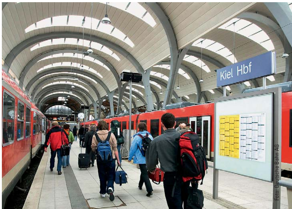
Züge der Deutschen Bahn AG am Kieler Hauptbahnhof
