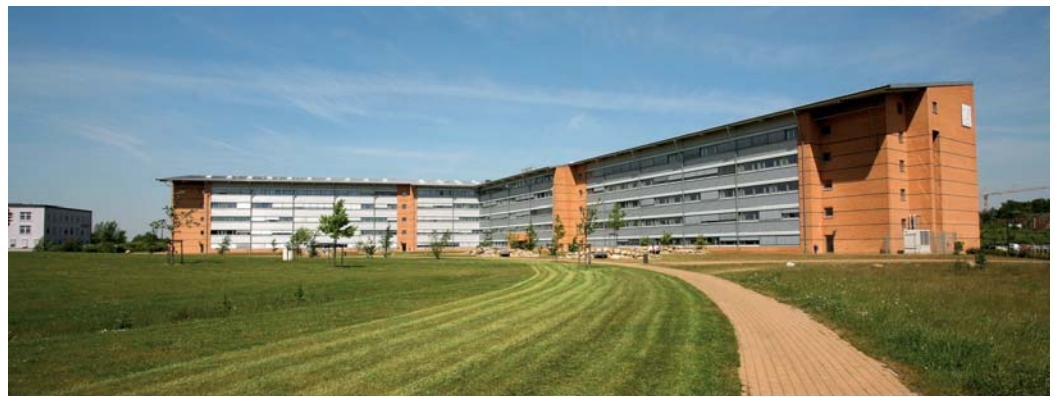
Das Hauptgebäude der Universität Flensburg.
