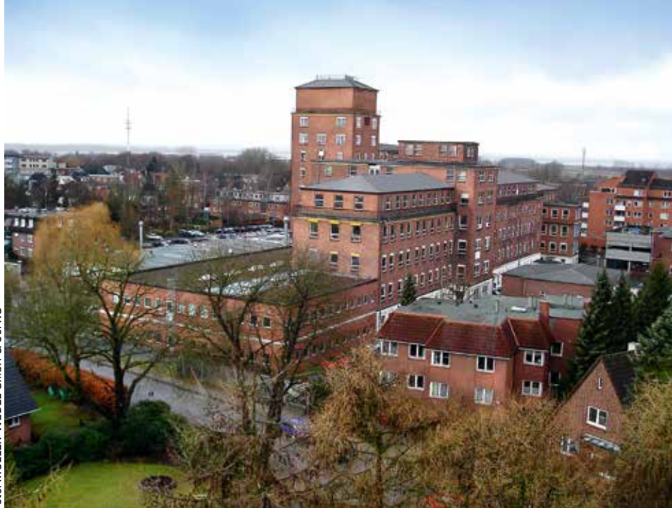
Das aktuelle Gebäude der Möller-Wedel GmbH 2014
