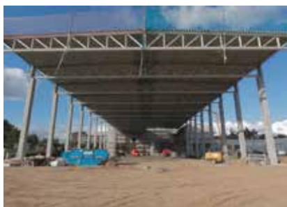
Dachkonstruktion bei Queisser Pharma.
