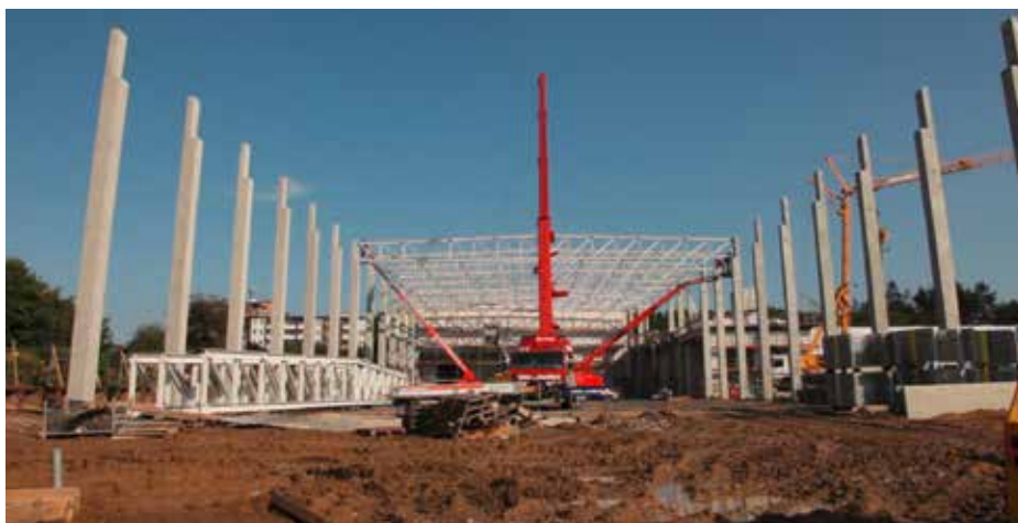
Eine neue Lager- und Versandhalle entsteht für Queisser Pharma.
