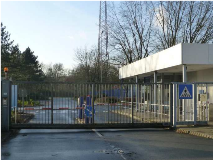
Abbildung 3: Durchführung AP2 Arbeitsauftrag
