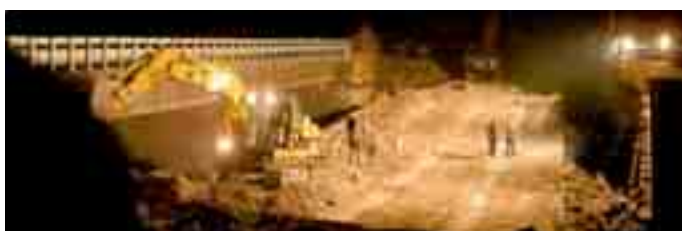
Autobahn-Vollsperrung: Die Spreng- und Demontage-Experten müssen innerhalb eines strengen Zeitrahmens fertig werden.
