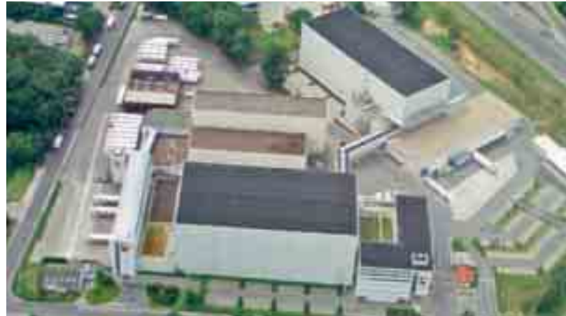
Im Hochregallager in Osnabrück wurden 2008 über 41000 neue Palettenplätze für die frischen Coppenrath & Wiese Tiefkühlprodukte geschaffen.
