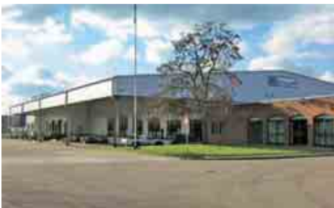
Projekt der Wittfeld UK Ltd: Binnen elf Monaten erfolgte in England der Hallenrück- und -neubau für die Firma Stauff in Sheffield.
