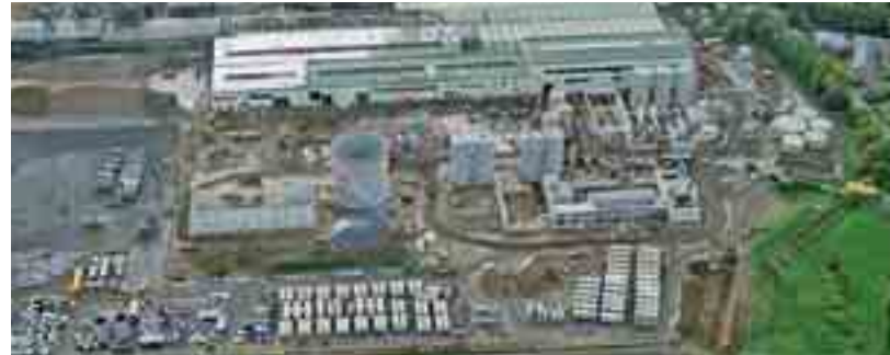
Stammsitz in Wallenhorst, Erfolg in Hexham Großbritannien: Blick auf die Baustelle der Firma Egger.
