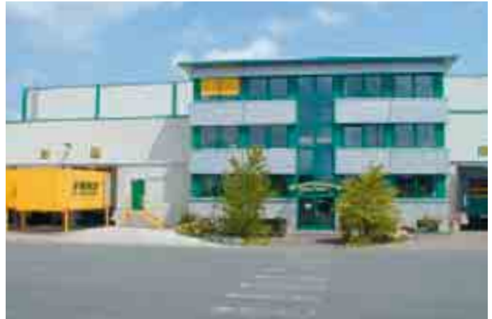
Synergieeffekte: Das Unternehmen profitiert von optimalen Logistikflächen am Standort Melle.
