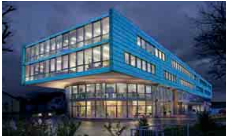
Die Sutthausener Straße 285/287 in Osnabrück: Bereits elf Unternehmen haben im architektonisch ansprechenden Office S 285/287 eine repräsentative Adresse gefunden.
