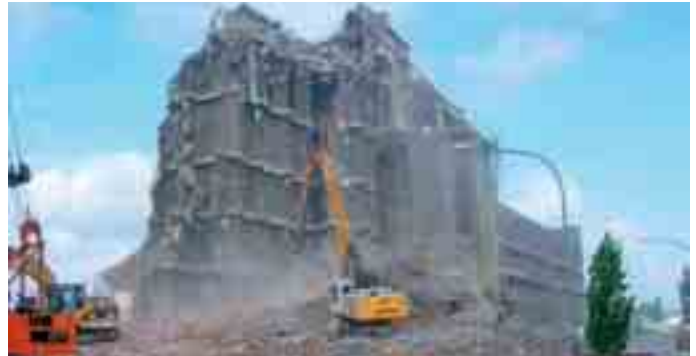
Alles auf Abbruch: Der Friedensspeicher in Osnabrück hinterließ dem Team 400 Lkw-Ladungen Bauschutt.
