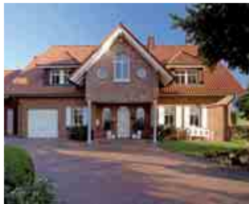
Ein gelungenes Beispiel für die Kombination von Pflasterklinker und Verblendmauerwerk.
