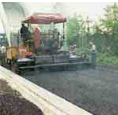
Splitte aus Elektroofenschlacke werden im Straßenbau genutzt.
