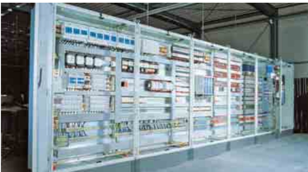
Hier entstehen komplexe Steuerungszentralen für verschiedenste Automatisierungs- und Industrieanlagen.
